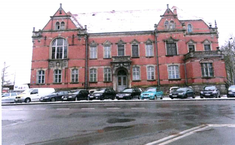
Fot. 2. Budynek widok od strony pół. - wsch., od ul. Kościuszki.
