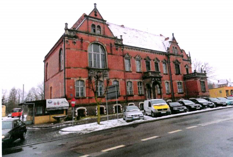
Fot. 3. Budynek widok od strony wsch., od ul. Kościuszki.
