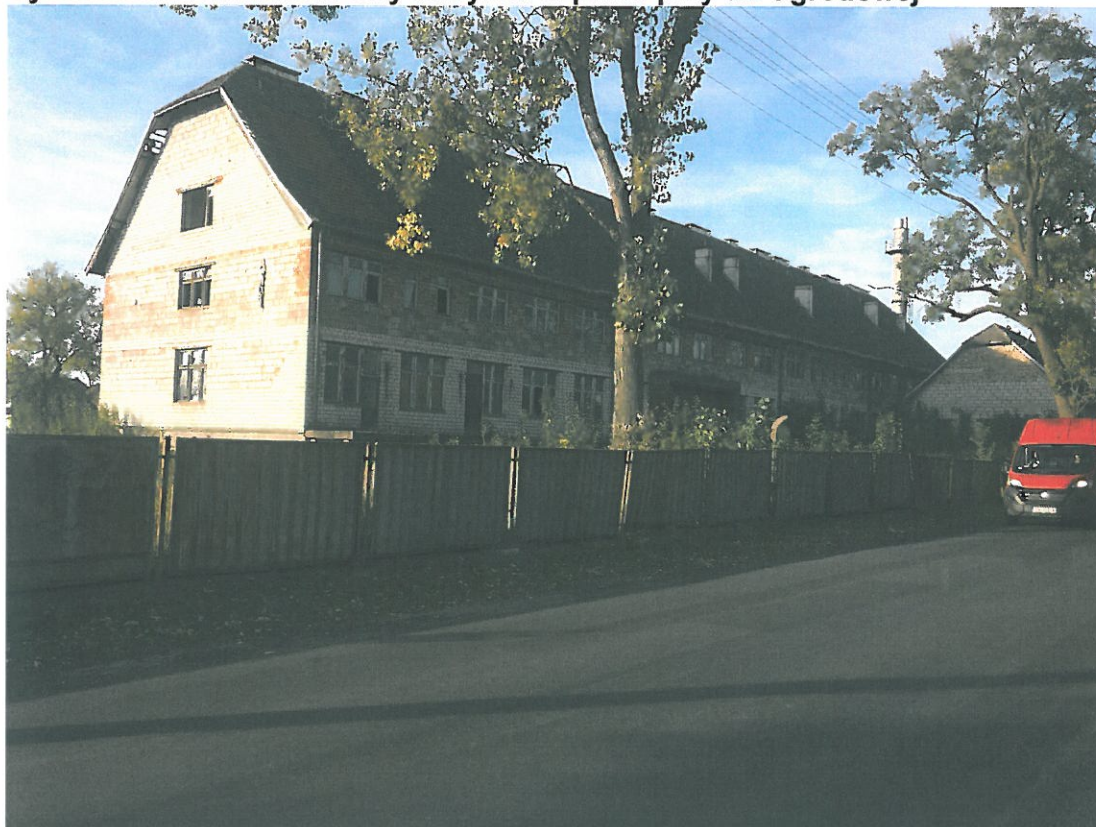
Rysunek 13. Niedokończony budynek szpitala przy ul. Ogrodowej
