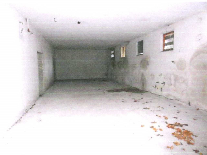
Fot. 18. Budynek piwnice.
