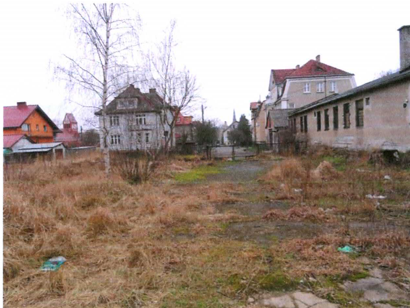
Fot. 8. Nieruchomość w części północnej, wjazd z ul. Demokracji Ludowej.
