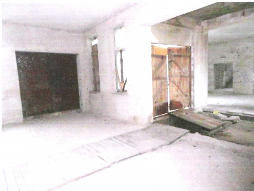
Fot. 28. Budynek łącznika, podjazdu karetek.
