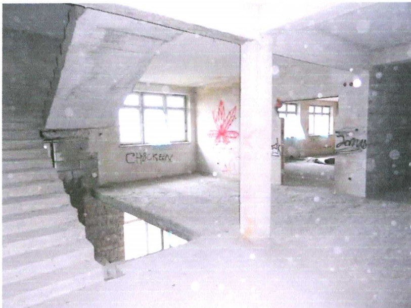
Fot. 31. Budynek piętro.
