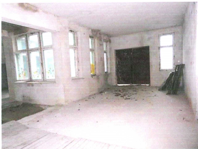
Fot. 29. Budynek podjazdu karetek.
