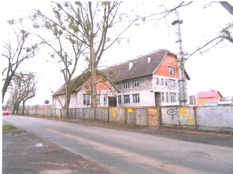
Fot. 1. Nieruchomość, widok od strony ul. Ogrodowej.
