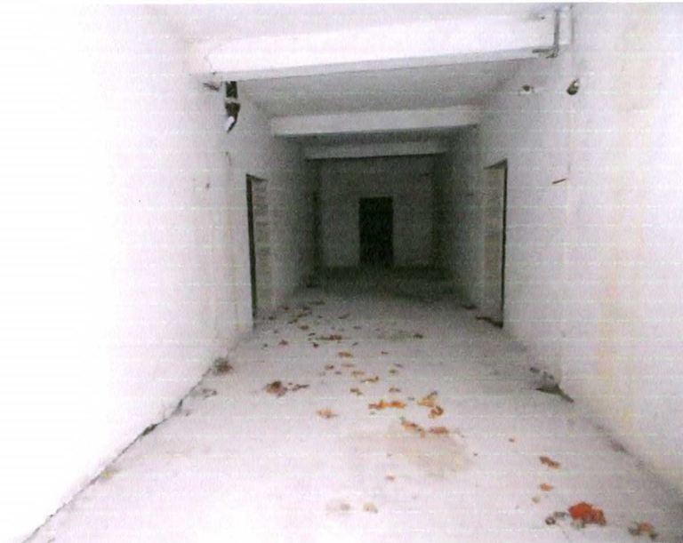
Fot. 16. Budynek piwnice.
