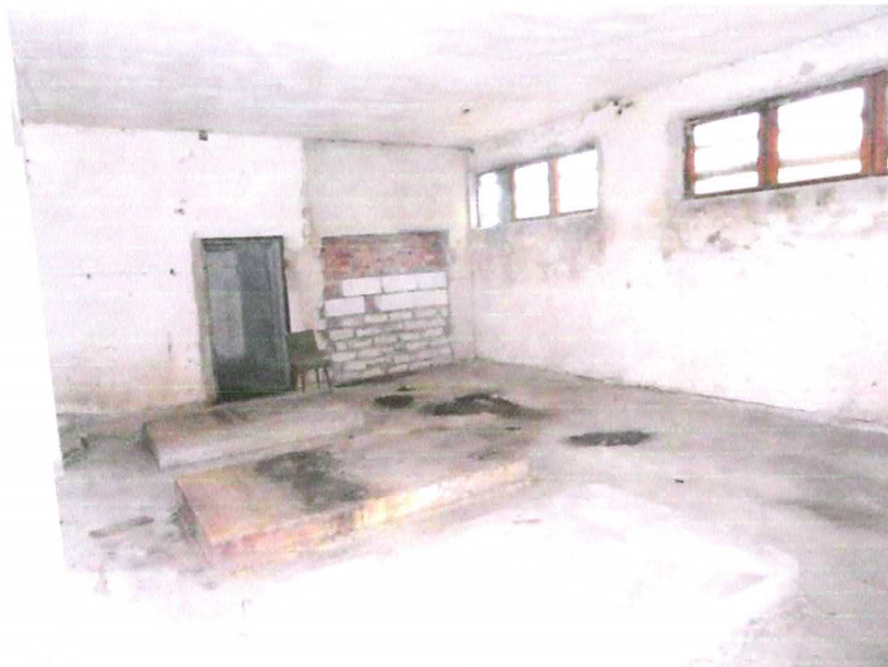
Fot. 17. Budynek piwnice.
