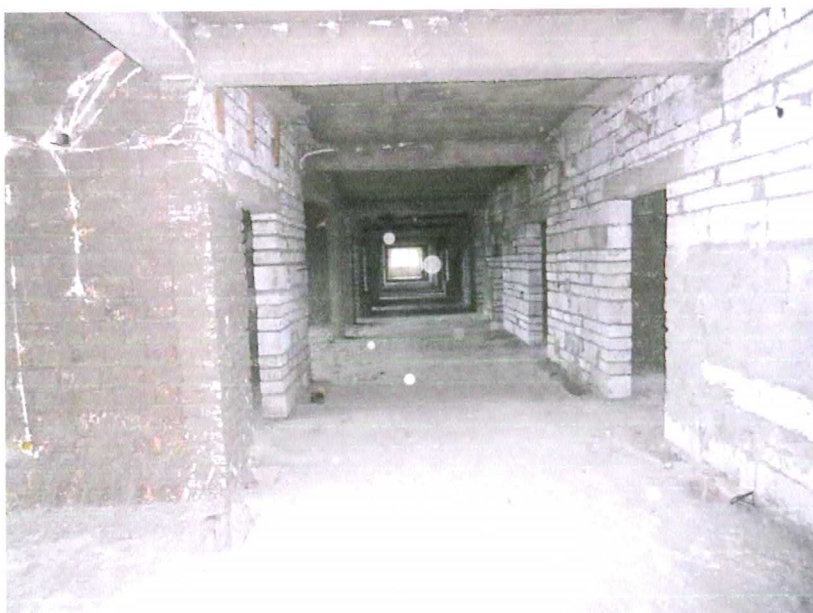
Fot. 33. Budynek piętro.
