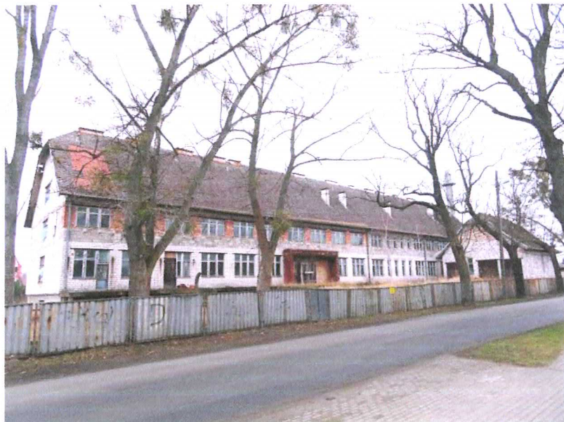
Fot. 2. Nieruchomość, widok od strony ul. Ogrodowej.
