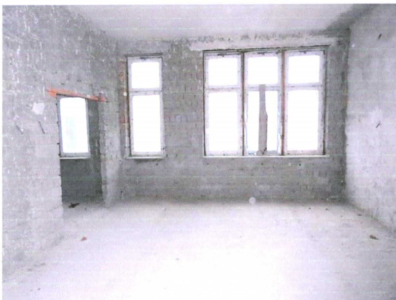
Fot. 23. Budynek parter.
