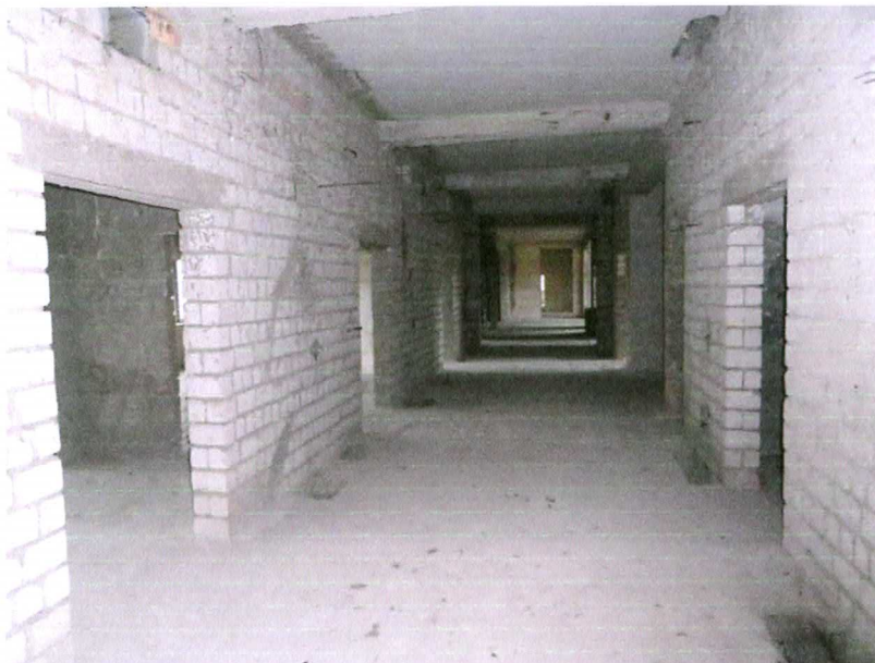
Fot. 22. Budynek parter.
