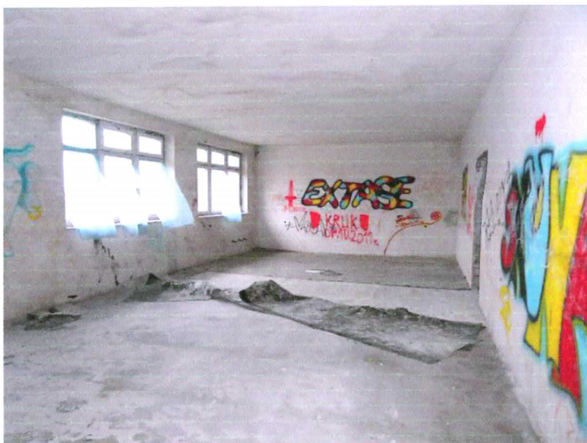
Fot. 32. Budynek piętro.
