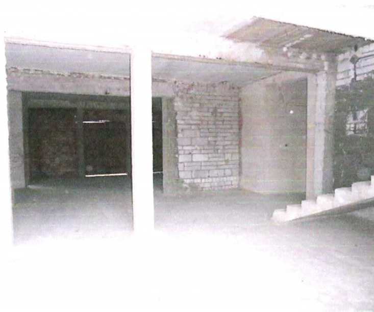
Fot. 24. Budynek parter.
