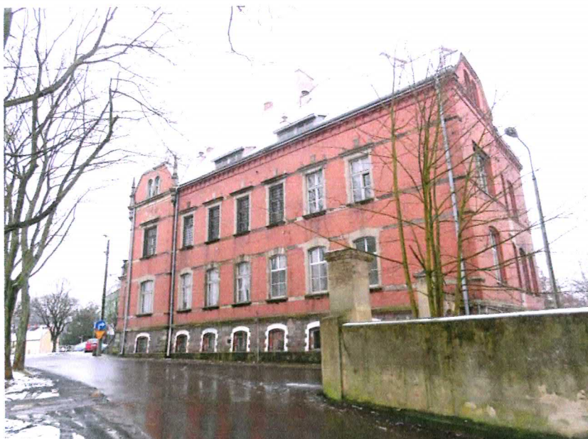
Fot. 6. Budynek, skrzydło zachodnie, widok od strony poł - zach., ul. Łąkowej
