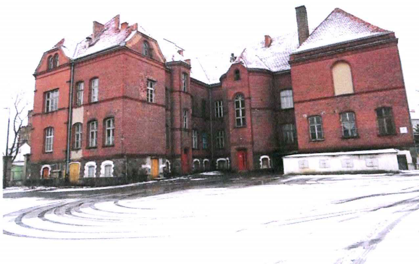
Fot. 5. Budynek widok od strony poł., podwórza.
