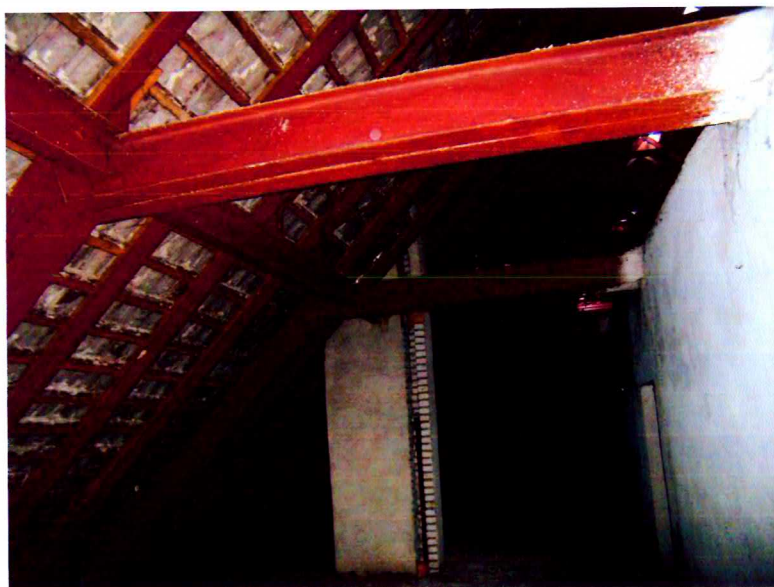
Fot. 18. Budynek, poddasze.
