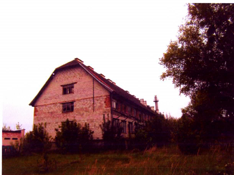
Fot. 3. Budynek, widok od strony ul. Ogrodowej.
