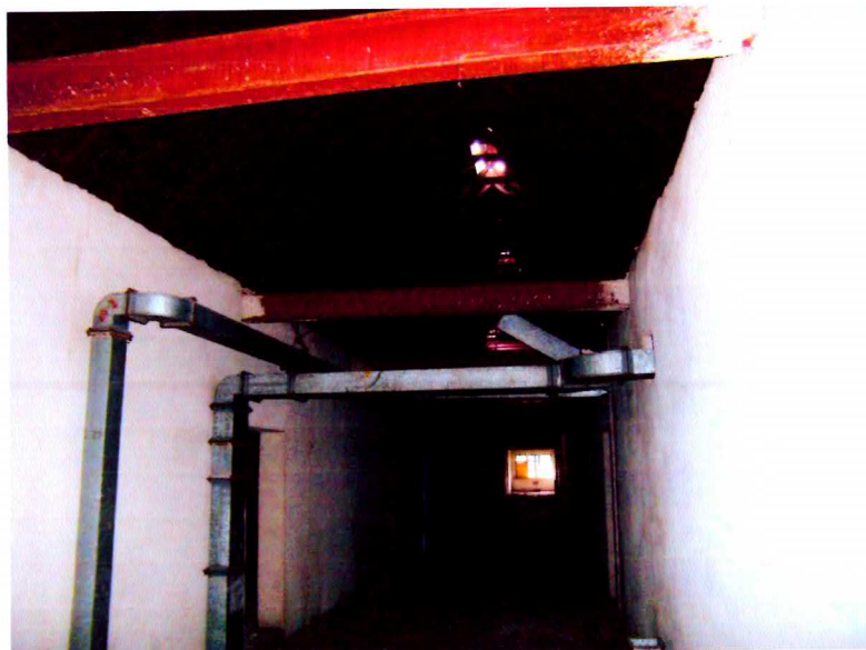
Fot. 17. Budynek, poddasze.
